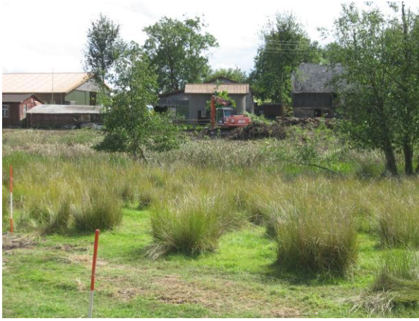
Foto 1: Sanierungsmaßnahmen auf dem Flurstück (August 2009)
