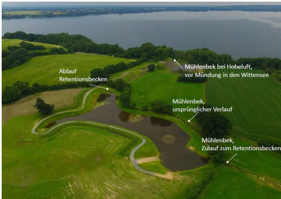
Abb. 1: Retentionsbecken Wittensee und Verlauf der Mühlenbek mit den verschiedenen Messstellen. Foto: Frank Steinmann
