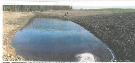
Das etwa 1500 Quadratmeter große, langgestreckte Gewässer ist durch die Regenfälle der vergangenen Tage bereits bis zum Überlauf gefüllt.
