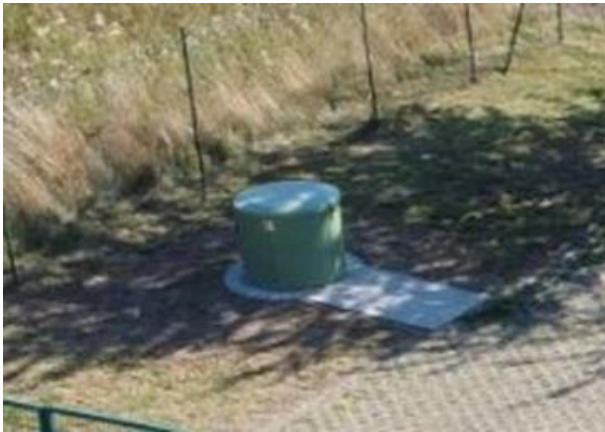
Fällmittelstation Eisen-III-Chlorid
