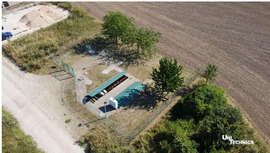
Kläranlage Kneese 350 EW
