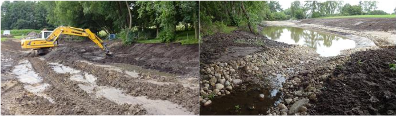
Abbildung 2: Links: Aushub des Sedimentationsbeckens; Rechts: Erstes Befüllen (König 2015)
