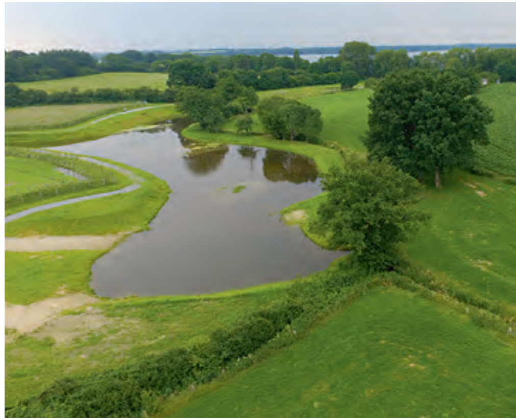
Das Retentionsbecken nach Fertigstellung, Juli 2017
