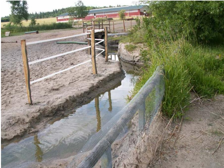
Abbildung 45: Uferbereich des Reiterhofes in der Freudenholmer Bucht mit punktueller Einleitung (Ablaufgraben) und erheblichen Trittschäden in Ufernähe
