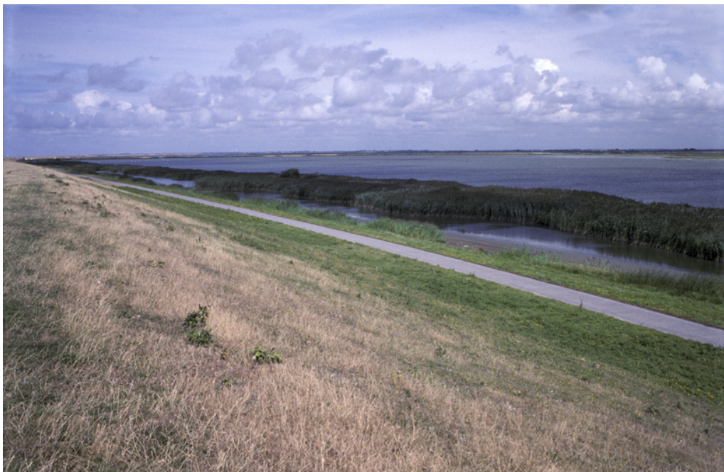
Foto 21: Blick vom Seedeich auf das südliche Westufer des Mahlbusen (Abschnitt 3). Hinter dem Weg ist rechts das grabenartige Gewässer landseits des eigentlichen Seeröhrichts zu erkennen, das die größten Tauchblattpflanzenbestände im Gebiet aufweist (Blickrichtung no).
