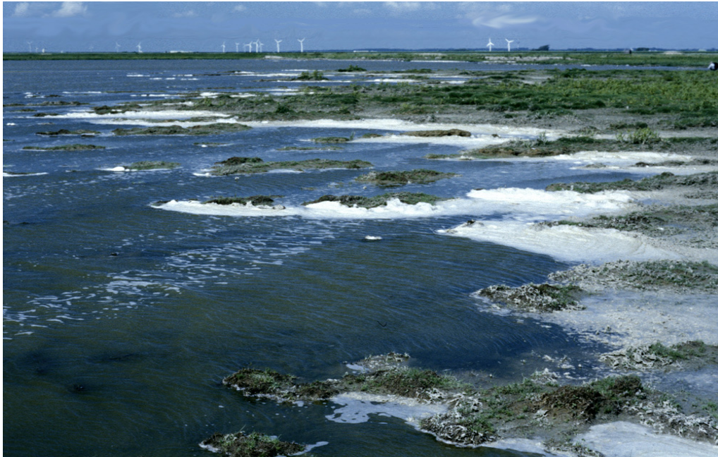
Foto 15: Blick von Süden über durch Wellenschlag erodierende Bereiche des Ostufers Richtung Nord (Abschnitt 2).
