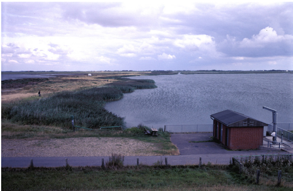
Foto 19: Blick über das Nordufer des Mahlbussen nach Osten. Im Vordergrund rechts bei dem Gebäude befindet sich der über ein Wehr geregelte Abfluß des Gewässers in die Nordsee (Blickrichtung o).
