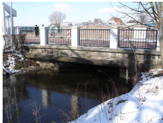
Abb. 48: links: Stemmtore mit hinterliegendem Wehr, rechts: Querschnittseingende Brücke
