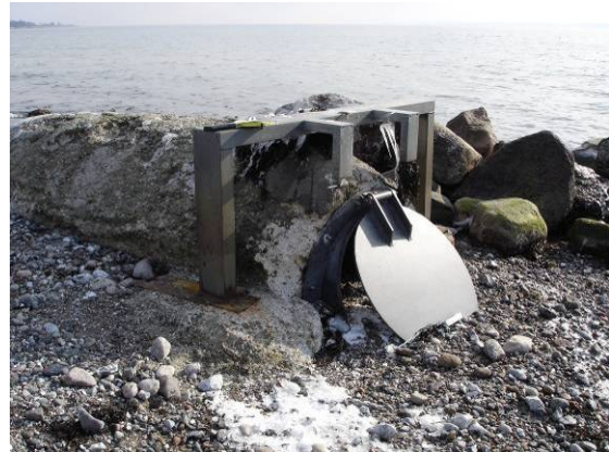
Abb. 34: links Brücke mit Rohrdurchlass; rechts Rohrdurchlass mit Rückstauklappe
