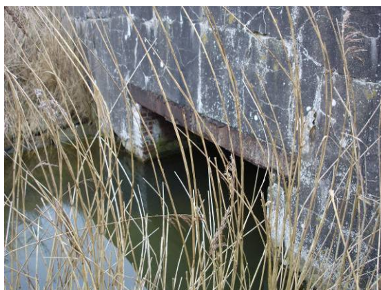
Abb. 72: links: Einlauf unterirdische Schleuse; rechts: Auslaufbauwerk Ostsee
