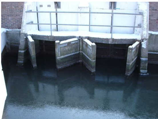
Abb. 48: links: Stemmtore mit hinterliegendem Wehr, rechts: Querschnittseingende Brücke
