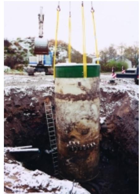
*... und mit einem Autokran wird der 5,25 Meter hohe Schacht aus der Grube gezogen.*
