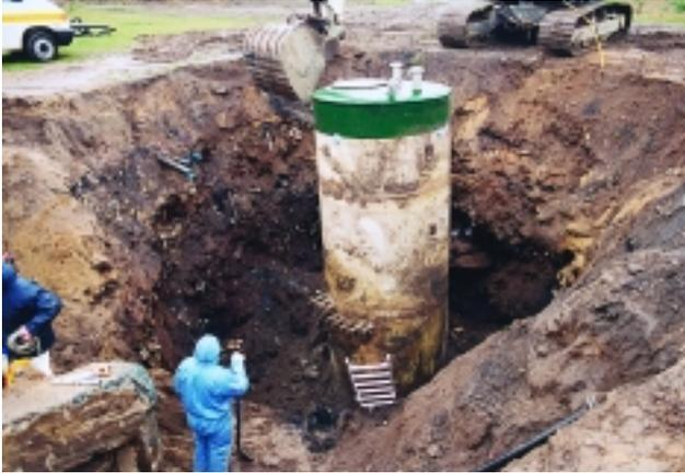
*Nach Demontage der Saugleitungen wird der Kondensatorschacht ausgegraben ...*
