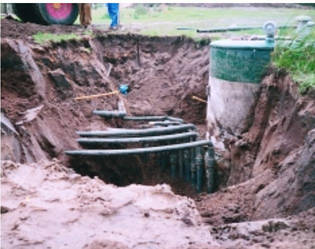
*Die Aufgrabung am Kondensatorschacht bringt einen sackungsbedingten Hohlraum unter Saugleitungen ans Tageslicht.*
