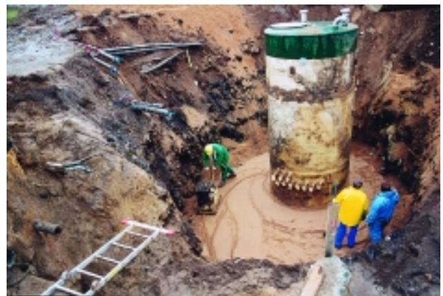
*Der Kondensatorschacht wird im lagenweise verdichteten Sand wieder eingebaut.*
