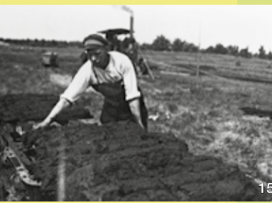
Bei der Bocktorfgewinnung wurde der von den Männern per Hand oder mit Hebmachines gelöste Torf in einem Trog zerkleinert, dann in Formen gepresst, in längere Stücke geschnitten und zum Trocknen aufgestapelt.
