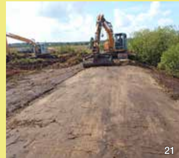
Der Weg von Hollbüllhuus nach Winnert wird um 80 cm erhöht.
