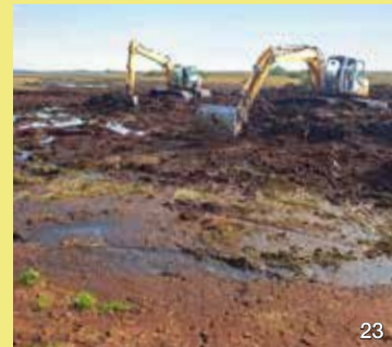
Die Verwallung wird errichtet.
