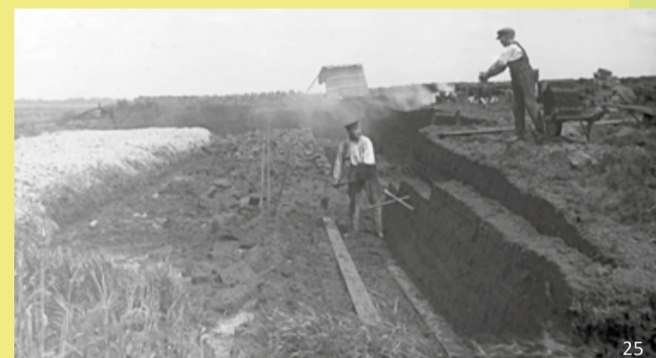
▲ Der Weißtorf ließ sich sehr gut schneiden und stechen. Die gestochnen Soden wurden von unten einem Helfer zugeworfen. ▼ Um 1930. Später wurden zum Transport des Torfes Loren auf Schienen eingesetzt.
