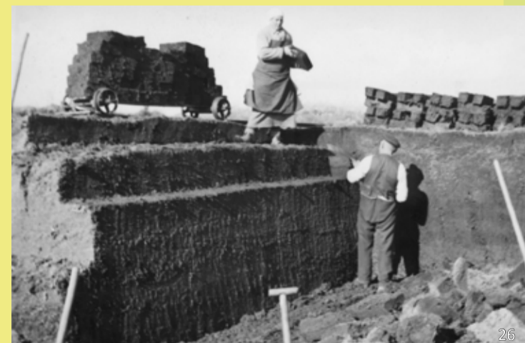
▲ Der Weißtorf ließ sich sehr gut schneiden und stechen. Die gestochnen Soden wurden von unten einem Helfer zugeworfen. ▼ Um 1930. Später wurden zum Transport des Torfes Loren auf Schienen eingesetzt.
