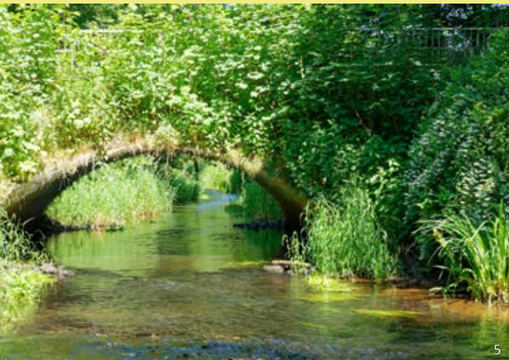
Durch Entfernung der Wehre der ehemaligen Sandfelder Schleuse wurde die Durchgängigkeit der Alster hier wieder hergestellt.
