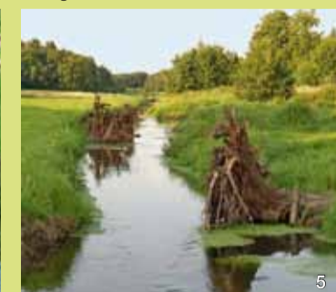
Eingebaute Störelemente sind die Keimzellen für die Bildung neuer Mäander.
