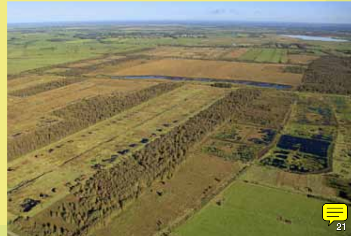
▼ Das Hartshoper Moor im September 2013. Nach Bau von Verwallungen und dem Verfüllen von Gräben (siehe links) ist die Mooroberfläche stark aufgequollen. Der Wasserspiegel bleibt ganzjährig auf Höhe der Mooroberfläche.
