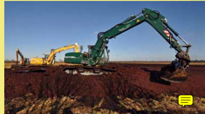
▲ Bagger beim Aufsetzen der Verwallungen
