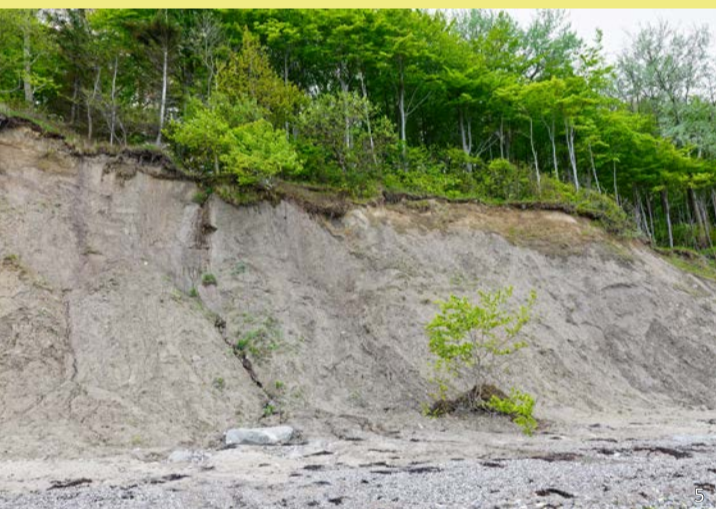
Am aktiven Kliff bei Dänisch-Nienhof kommt es immer wieder zu Kliffrutschungen und -abbrüchen. Dabei rutschen auch intakte Bäume an den Strand.
