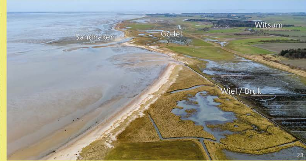
Luftaufnahme nach der Sturmflut im Februar 2022, Blickrichtung Westen. Weite Bereiche der Niederung stehen unter Wasser.
