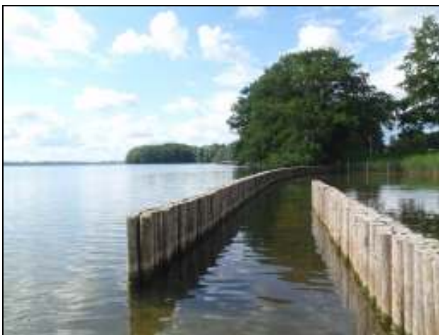
Foto 63 und 64: Maßnahmen zum Schutz des Röhrichts. Seeseitige Öffnung der doppelreihigen Befestigung aus Holzpfählen (links) und Blick auf von Holzpfählen vor Wellen geschütztem Flachwasserbereich sowie die Röhrlichtzone (rechts).
