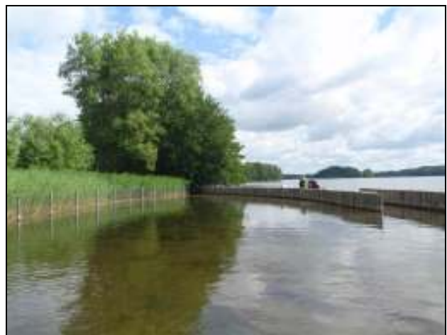
Foto 63 und 64: Maßnahmen zum Schutz des Röhrichts. Seeseitige Öffnung der doppelreihigen Befestigung aus Holzpfählen (links) und Blick auf von Holzpfählen vor Wellen geschütztem Flachwasserbereich sowie die Röhrlichtzone (rechts).
