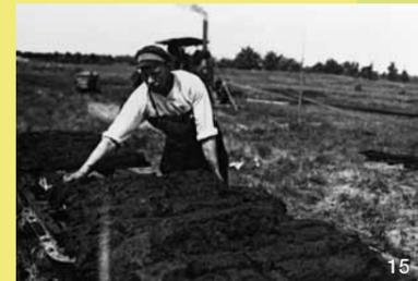
Bei der Bocktorfgewinnung wurde der von den Männern per Hand oder mit Hebmäschinen gelöste Torf in einem Trog zerleinert, dann in Formen gepresst, in längere Stücke geschnitten und zum Trocknen aufgestapelt.
