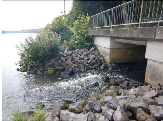
Abbildung 17: Sohlgleite an der Mündung der Gieselau zum NOK.
