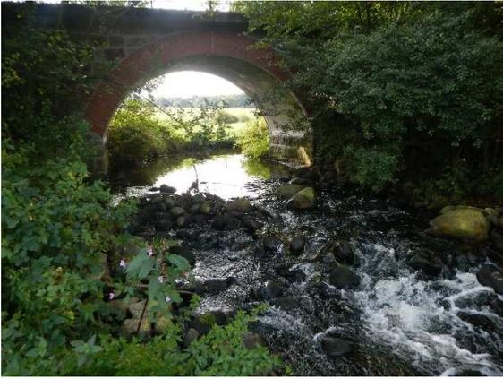
Abbildung 16: Sohlgleite beim alten Bahndamm.
