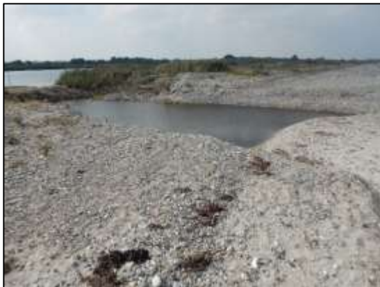
Abbildung 15: Künstliche Öffnung der Lagune im NSG Strandseelandschaft bei Schmoel zur Ostsee, zur Verhinderung eines Rückstaus ins Hinterland. (Foto: H. Hollenbach)
