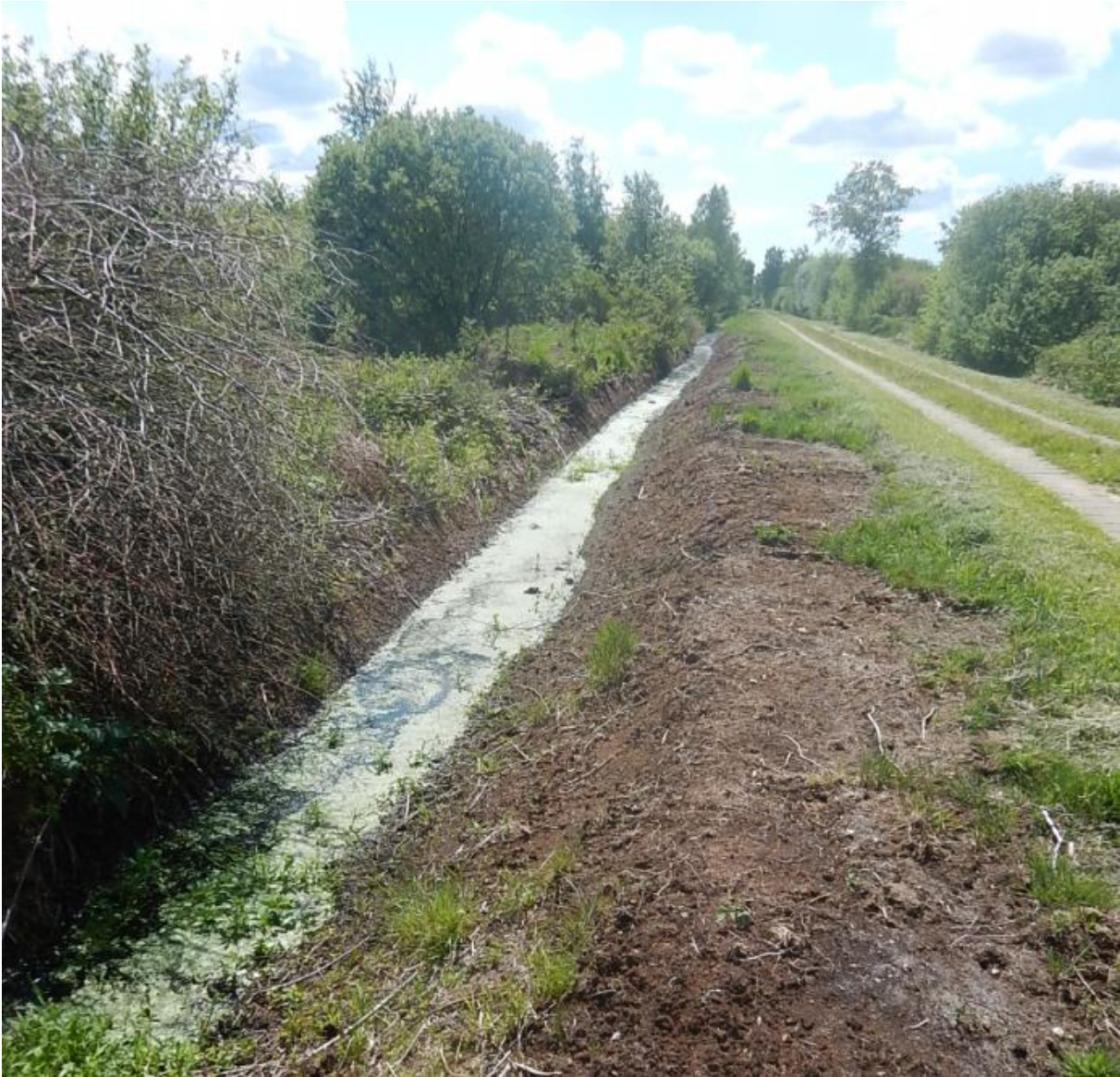
Abbildung 9: Spurplattenweg mit frisch geräumtem Wegeseitengraben im Dörpinger Moor (Foto: Malte Unger 2020).
