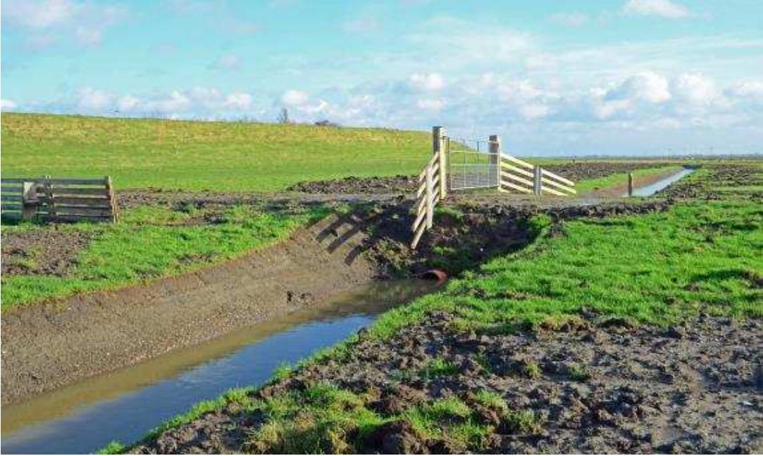
Abb. 13: Deichfußgraben vor dem Olversumer Vorland, Grabenanstich 2013
