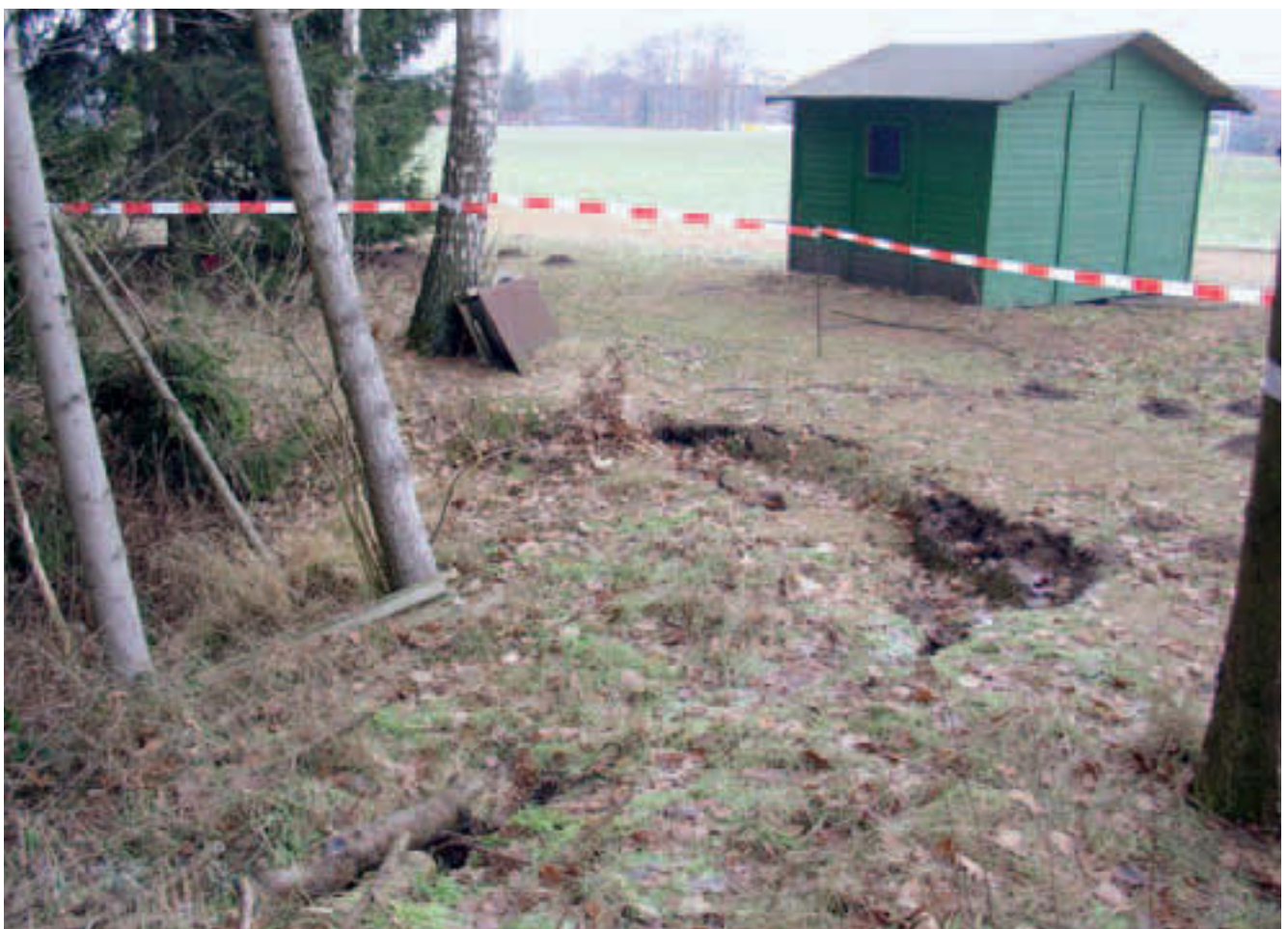
Abbildung 5: Junger Erdfall über Schreibkreide bei Münsterdorf mit „betrunkenen Bäumen“. Hier führten unterirdische Lösungsprozesse zur Höhlenbildung, diese Hohlräume sind kollabiert.
