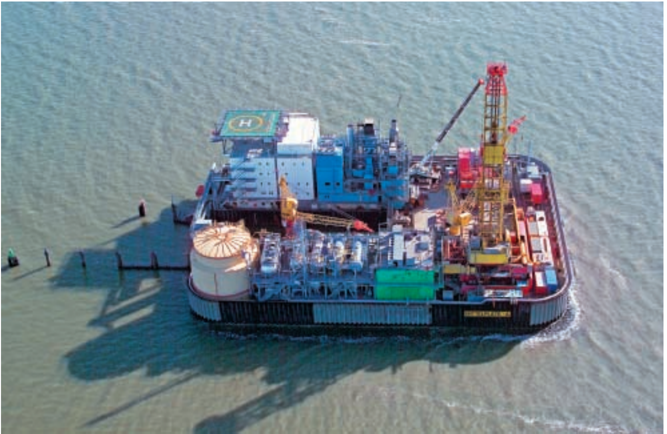
Abbildung 2: Erdölförderplattform Mittelplate im schleswig-holsteinischen Wattenmeer (Quelle: RWE Dea)
