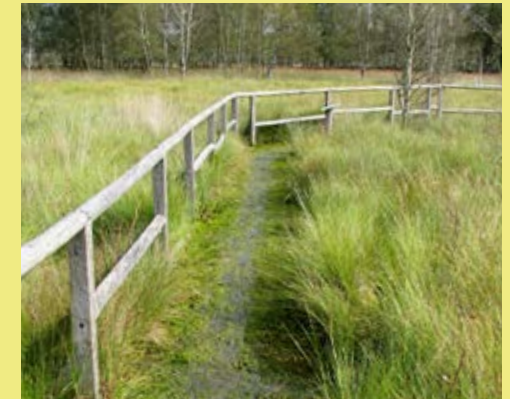
Torfmoose hatten den alten Bohlenweg überwachsen, der deshalb ersetzt werden musste. (Foto: Pütz)
